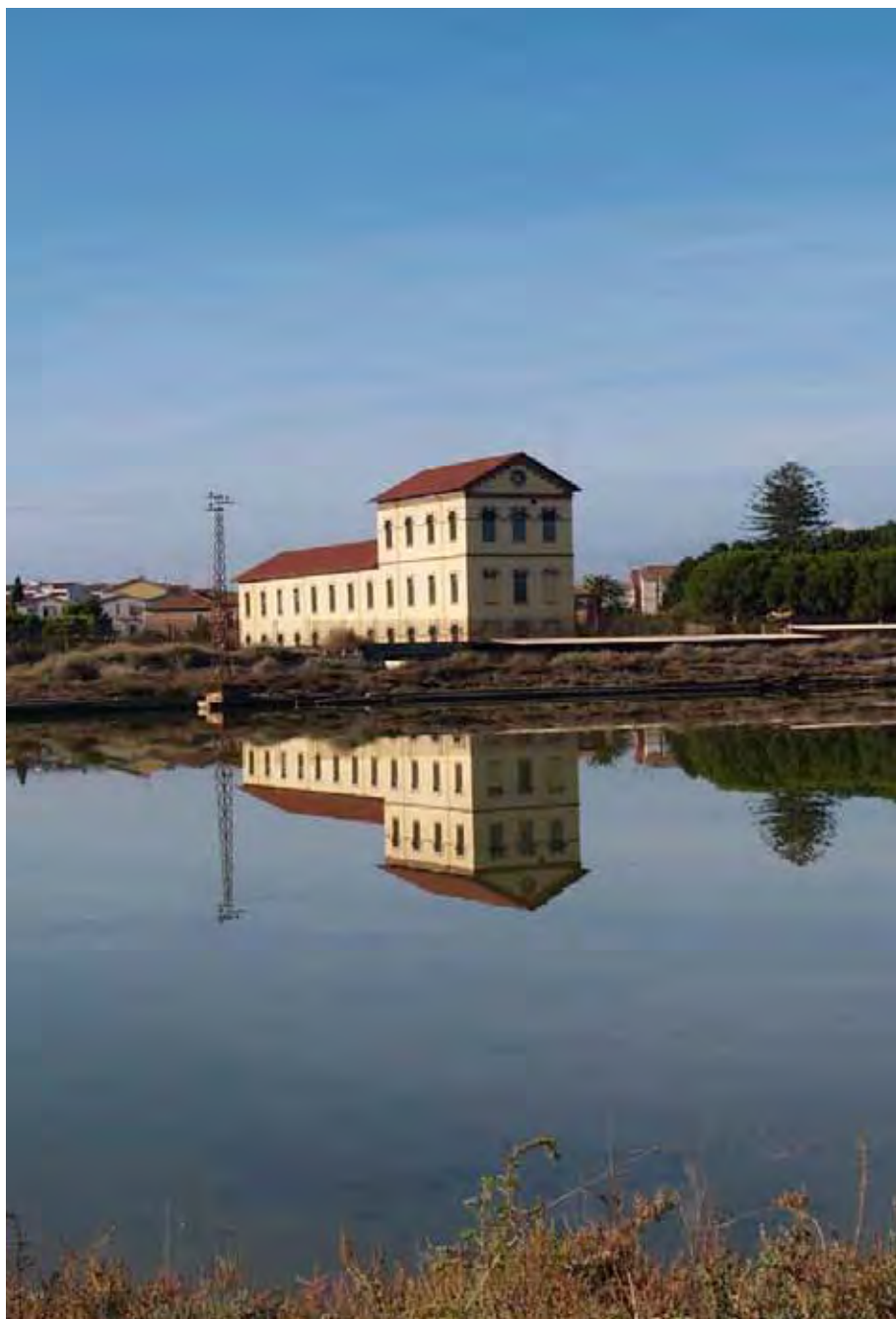
Edificio Sali Scelti, sede del Parco (Foto A. Atzeni)
