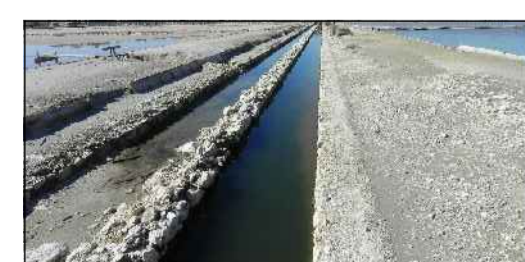
Canale con sponde in pietra calcarea apparecchiati con allettamento in malta di calce senza corsi di spianamento.
