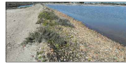
Bordo-vasca in ciottoli aventi il compito di proteggere il sottofondo in argilla dal moto ondoso.
