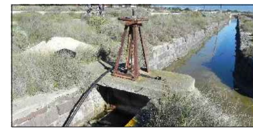
Paratoia in cls e legno realizzate in epoche successive sui canali esistenti in pietra.
