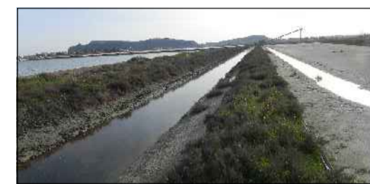
Canale con sponde in terra.
