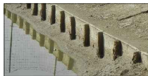
Tipologia con sponde verticali in tavolato, sostenute da pali lignee a sezione quadrata.
