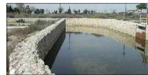
Canale immissario (drovora del Poetto-Molentargius) realizzato in C.A. e rivestito in pietra calcarea.
