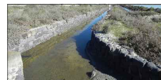
Canale con sponde in conci squadrati di basalto apparecchiati secondo corsi orizzontali regolari, fondo in argilla.
