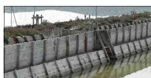
Tipologia con sponde rialzate in tavolato, sostenute da pali lignee.
