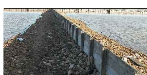
Argini in terra e ciottoli con elemento divisorio/frangivento realizzato con doppi pali a sezione quadrata e tavolato in abete.
