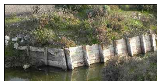
Tipologia con sponde inclinate in tavolato, sostenute da pali lignee a sezione circolare e quadrata.
