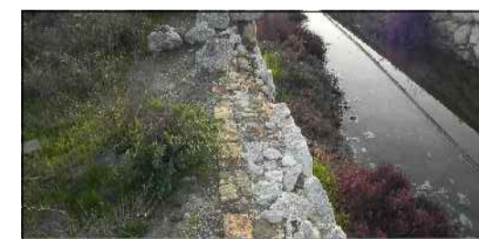
Canale con sponde in pietra calcarea apparecchiati con allettamento in malta di calce senza corsi di spianamento. Copertina protettiva in cls.
