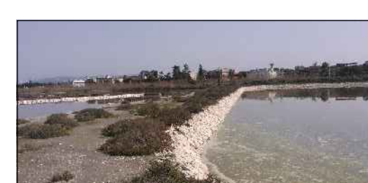
Rivestimento lapideo delle sponde delle vasche-deposito mediante massi di pietra calcarea.
